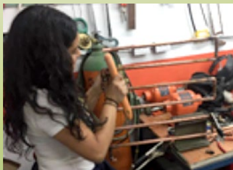
Soldadura de la tubería en forma de serpentina
